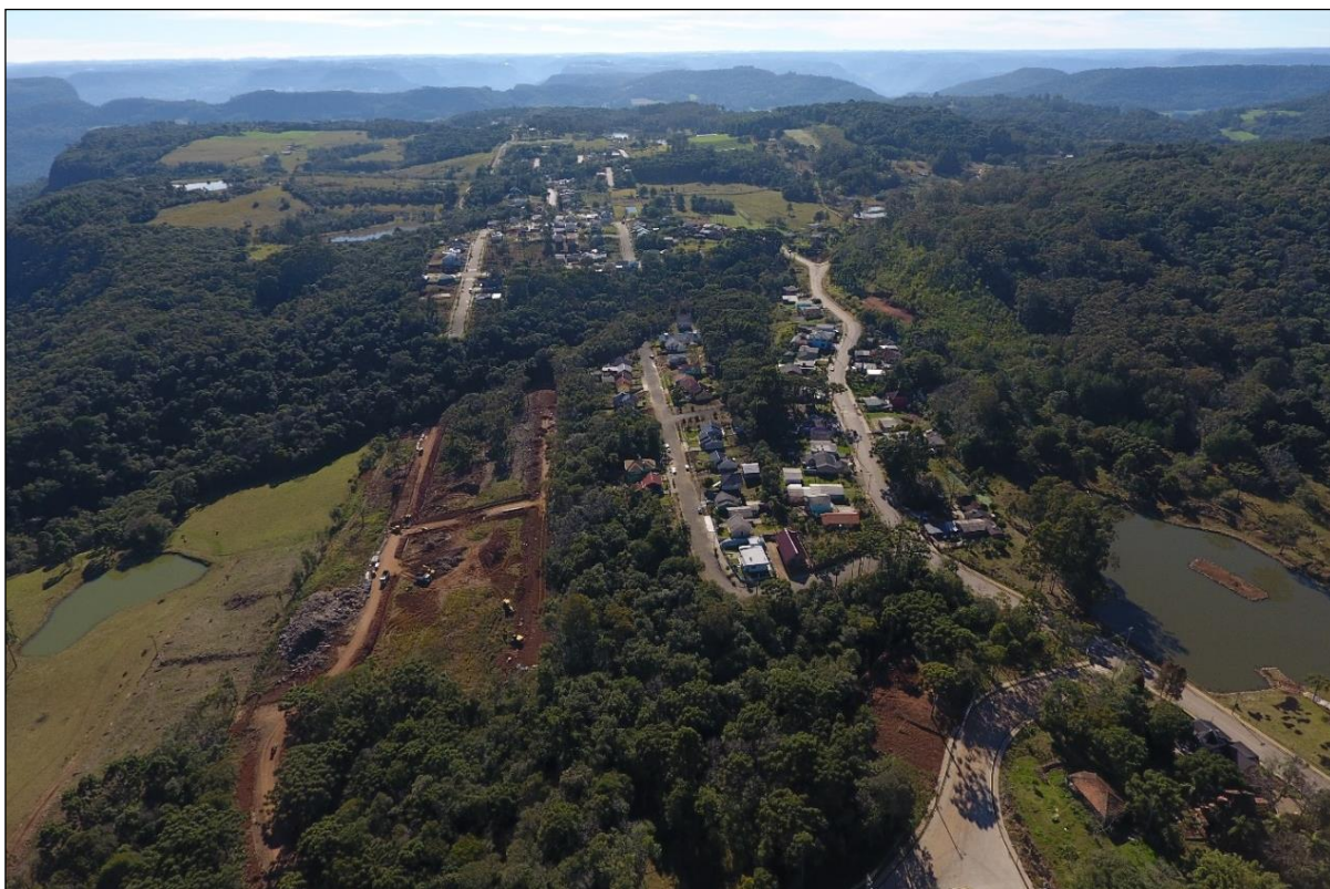
Figura 41. Vista aérea dos adensamentos populacionais ocorrentes ao norte da área de estudos. Fonte: acervo Atagon (2021).
