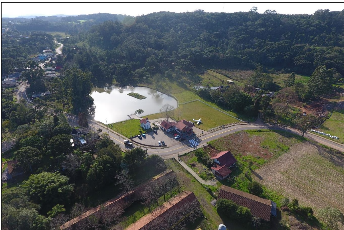
Figura 42. Vista aérea do entorno do empreendimento, ao norte. Fonte: Atagon (2022).
