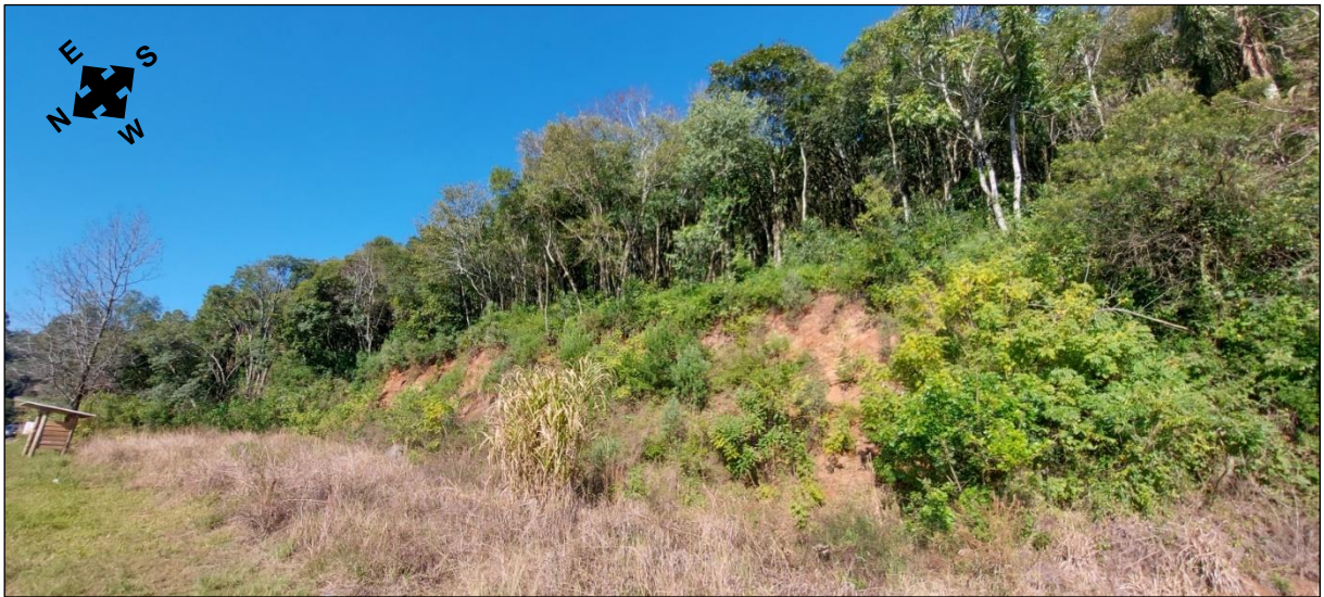
Figura 24. Registro fotográfico da área de estudo com visada para direção leste-sudeste (E-SE). A forma da vertente às margens da rodovia RS-235 na área de estudo apresenta perfil retilíneo confluyente para norte (N). Fonte: Atagon (2022).
