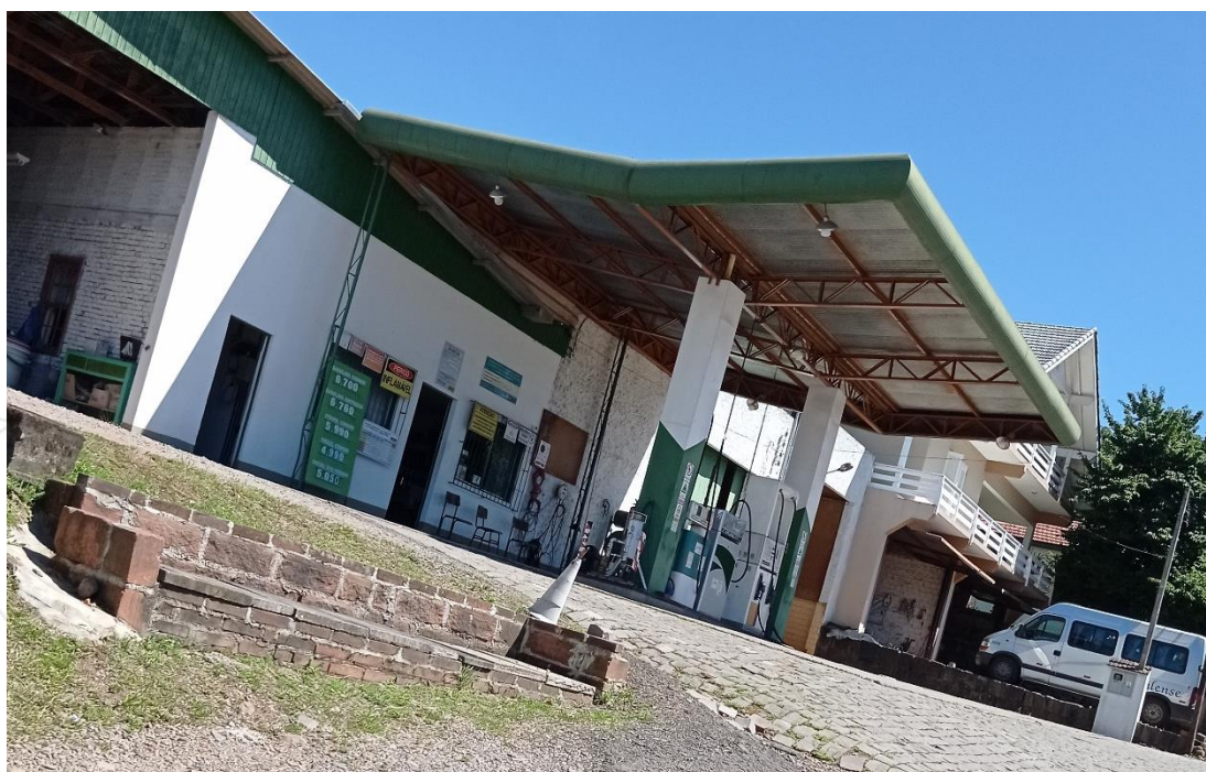
Figura 6 – Posto de Gasolina no entorno do empreendimento.
